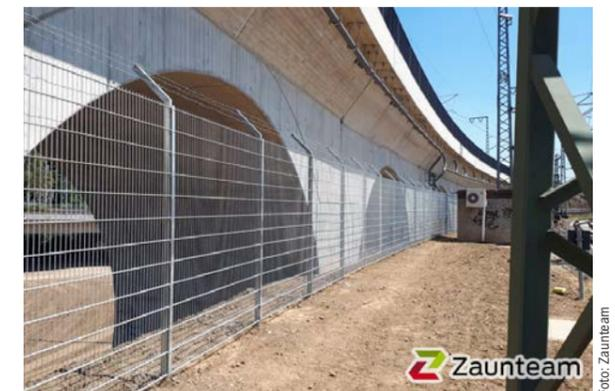
Für Sicherheitsumzäunungen über Kilometer werden gern Doppelstabmatten eingesetzt.
