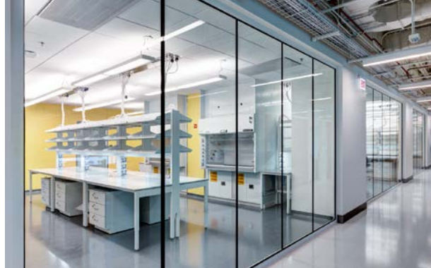
Contraflam Structure 30 Vetrogard RC2/RC4 ist laut Hersteller die erste flächenbündige Brandschutzglaslösung für Innentrennwände mit integriertem Einbruchschutz.
