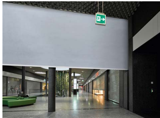
Durch den Feuerschutzvorhang FlexFire können große Öffnungen im Brandfall innerhalb von wenigen Sekunden abgeschlossen werden.
